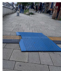
... und weiter über sehr komfortabel verkleidete Kabelkanäle.
